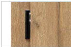
Drei praktische Türbänder mit jeweils 2 Gewindestiften sind in ein massives vertikales Rahmenholz mit Stärke von 40 mm eingelassen (optional Kappen)
